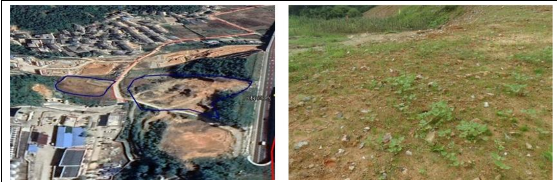
湖岭背出口左处中转料场（左：施工时，右：恢复后）
