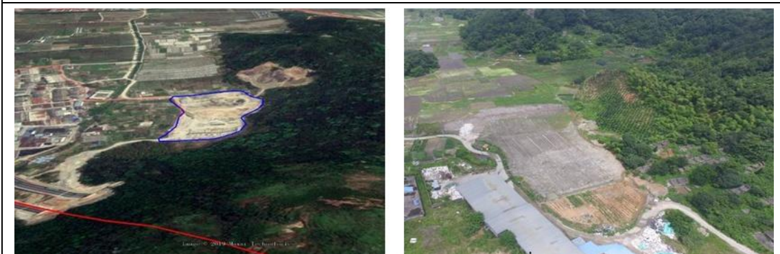
岙岭隧道进口左处中转料场（左：施工时，右：恢复后）
