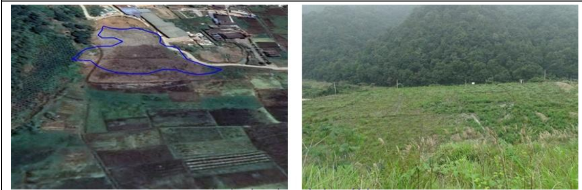
横山隧道出口左中转料场（左：施工时，右：恢复后）
