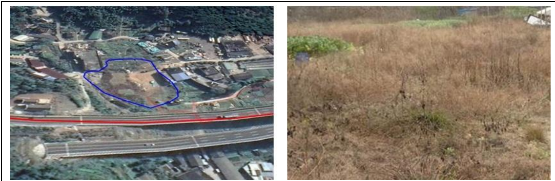
乌岩尖隧道出口中转料场（左：施工时，右：恢复后）
