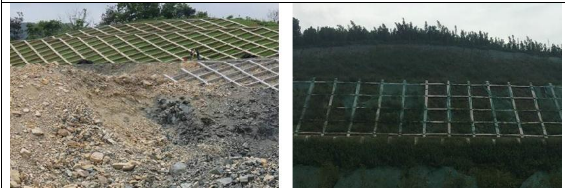
K19+500 处开挖边坡（左：施工时，右：恢复后）
