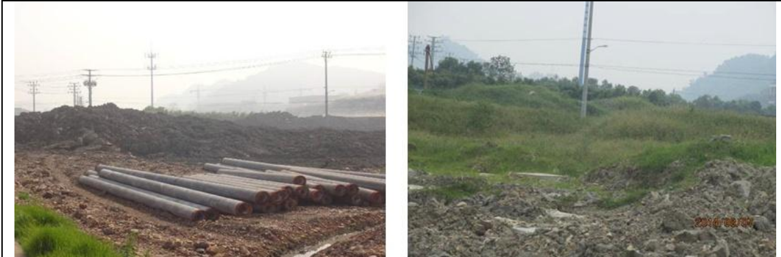
K13+500 处临时堆土场（左：施工时，右：恢复后）
