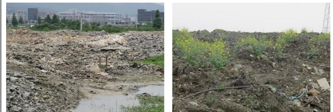
K51+500 处临时堆土场（左：施工时，右：恢复后）
