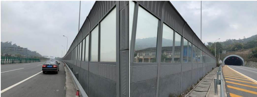
图6.4-1 本工程声屏障安置情况
