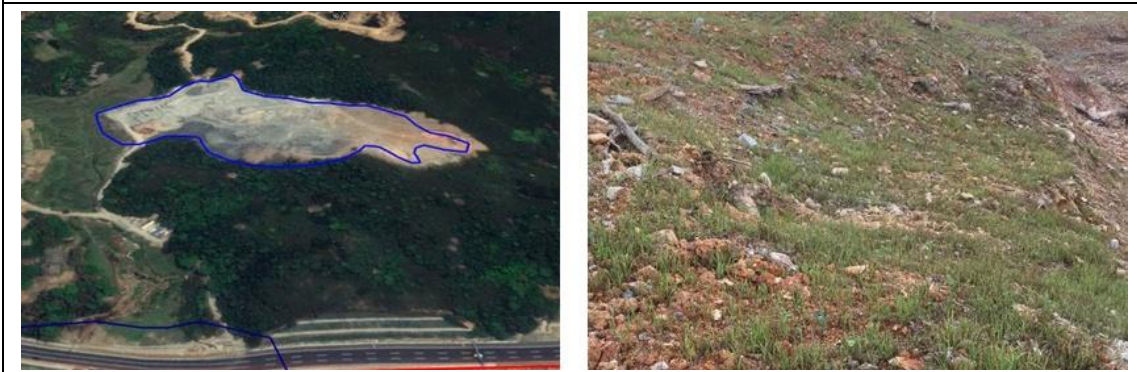
太平山隧道处中转料场（左：施工时，右：恢复后）
